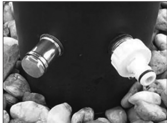
Tömningshåll med propp (t.v.), Inloppet med slangkoppling (t.h.)
