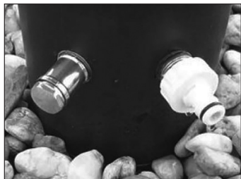
Izpustna odprtina s čepom (levo), dovodna armatura s cevnim zaključkom (desno)
